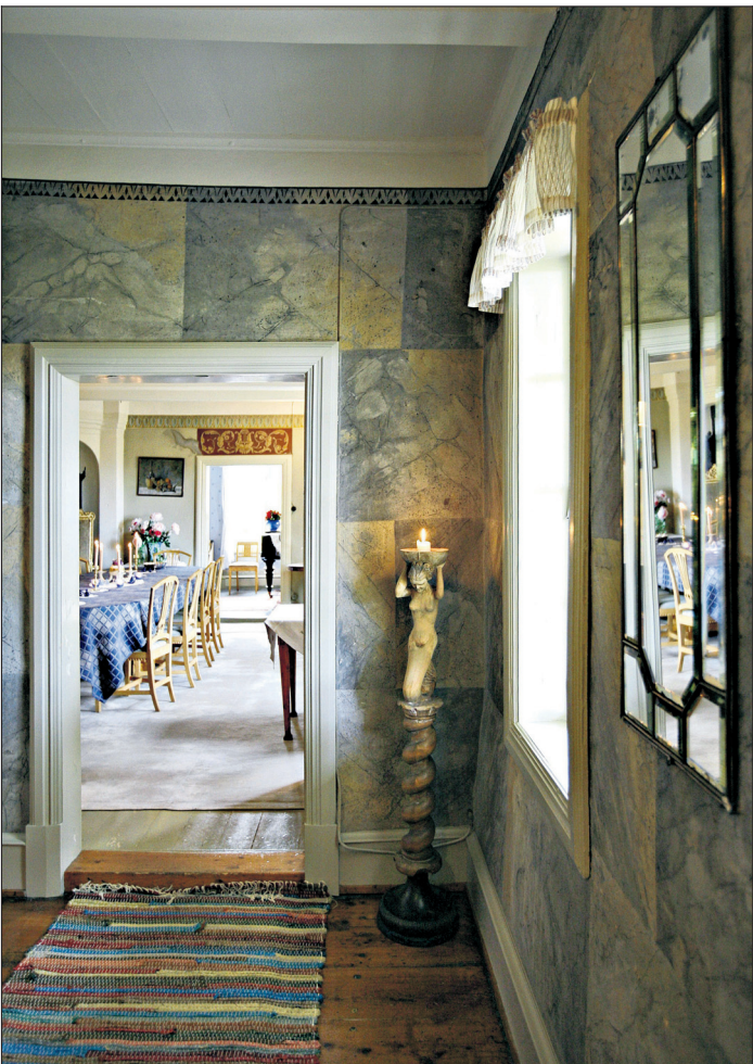
Veggene i gangen mot terrassen er rappet og marmorert. Rappingen består av en blanding av leire, sand og linfiber. Det gir større fleksibilitet enn ren murpuss. Marmoreringen er original fra 1795, og fargene har holdt seg uendret. Rommet innenfor er spisestuen.
