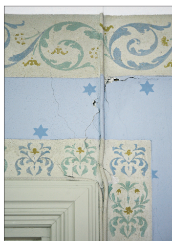
Det får store økonomiske konsekvenser å pusse opp et fredet hus.
